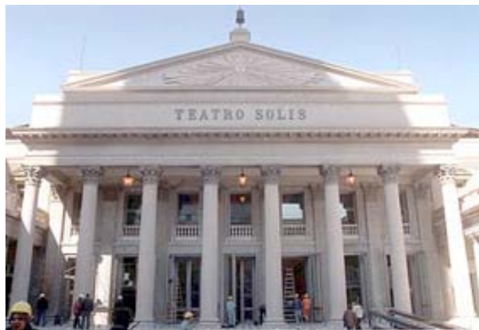
La fachada clásica del edificio central casi terminada.
